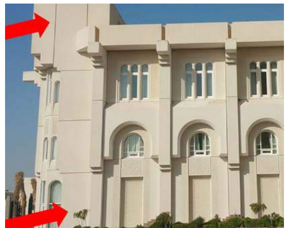
Παλάτι φτιαγμένο από τσιμεντοειδή σοβά. Το επάνω μέρος της σοβατισμένης πρόσοψης είναι κιτρινωπό ενώ το κάτω μέρος καθαρό και φρέσκο μετά από έντονη προσπάθεια συντήρησης και καθαρισμού.
