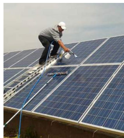
Εφαρμογή του SurfaShield G σε προεγκατεστημένα πάνελ.
