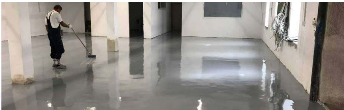
Εφαρμογή EPFNova χωρίς διαλύτη, σε εποξειδικό δάπεδο.
