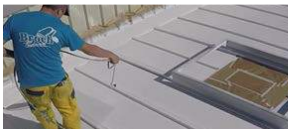
Εφαρμογή του SurfaPaint ThermoDry Elastomeric Roof στην προετοιμασμένη επιφάνεια.
