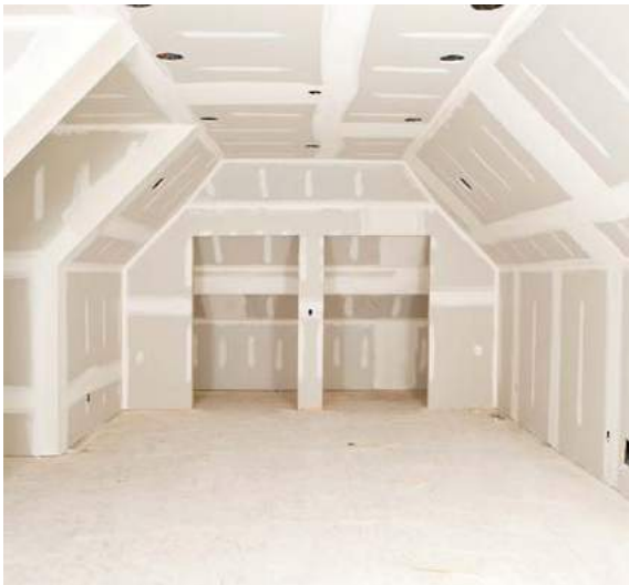
Εφαρμογή του SurfaPore F ως αστάρι σε γυψοσανίδα, πριν από την τελική εφαρμογή χρώματος.
