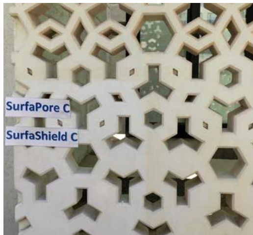
Επιφάνεια ινοοπλισμένου σκυροδέματος (GRC). Είναι εμφανής η μείωση της συσσώρευσης βρωμιάς στην επεξεργασμένη με το σύστημα NanoPhos επιφάνεια.
