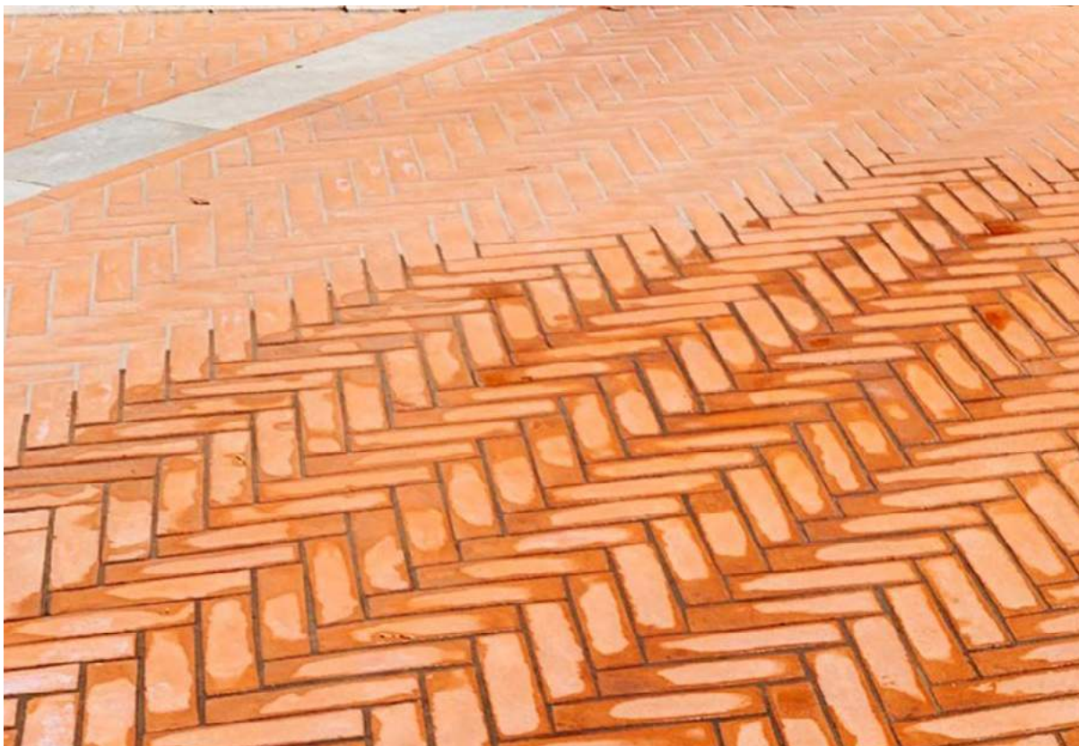
Πρόσφατη επεξεργασία απομάκρυνσης της εξάνθησης επιφάνειας τούβλων τύπου cotto με το σύστημα της NanoPhos (κάτω δεξιά, βρεγμένο μέρος) έναντι μη επεξεργασμένης περιοχής (πάνω αριστερά, στεγνό μέρος). Το τελικό στάδιο της θεραπείας με την εφαρμογή του SurfaPore C δεν έχει ολοκληρωθεί.
