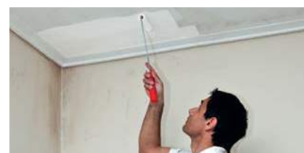
Αφαίρεση της μούχλας με DeSalin AM και στη συνέχεια βάψιμο με SurfaPaint AquaX.
