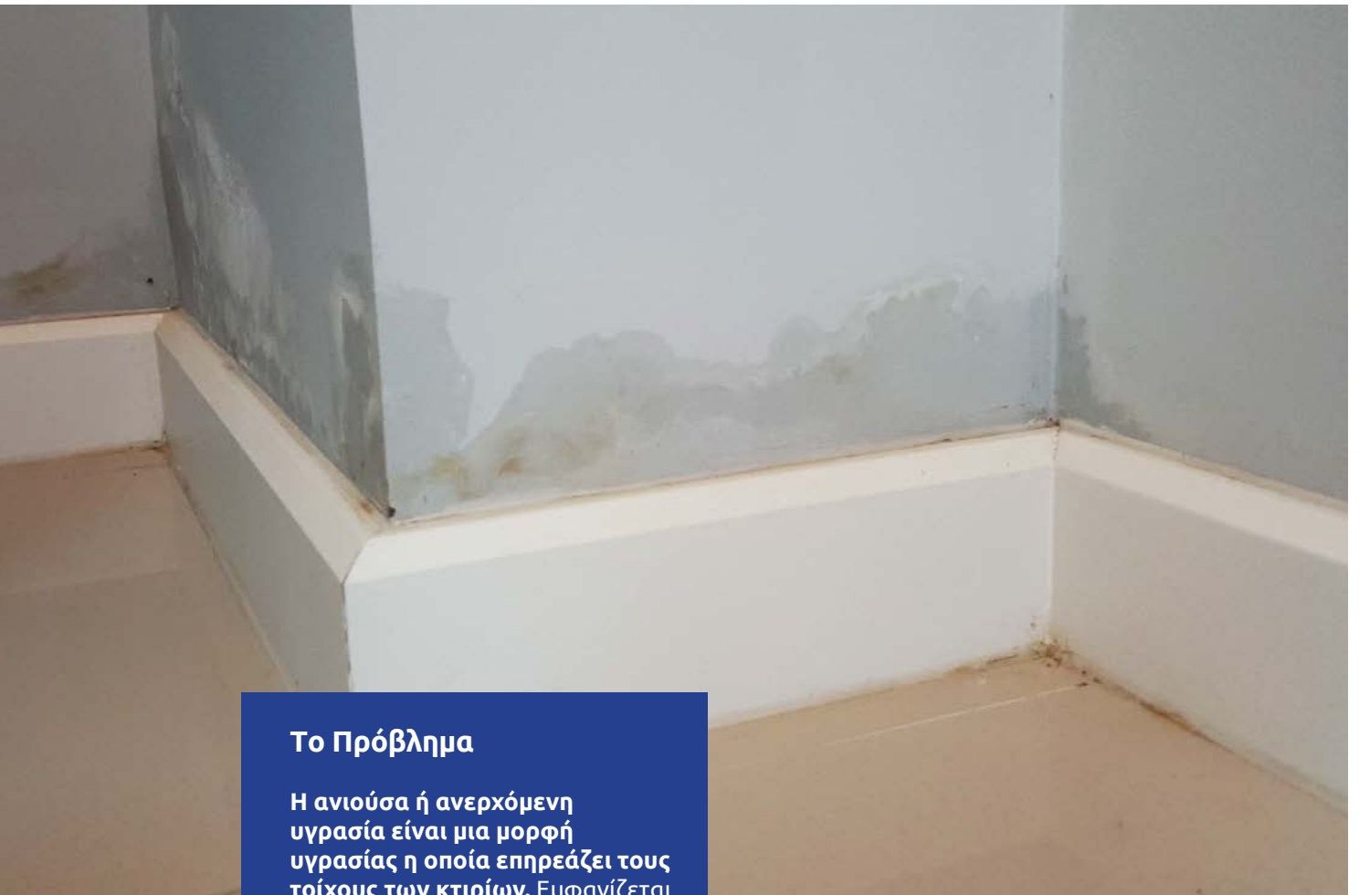
Ανιούσα υγρασία σε εσωτερικό τοίχο σπιτιού.
