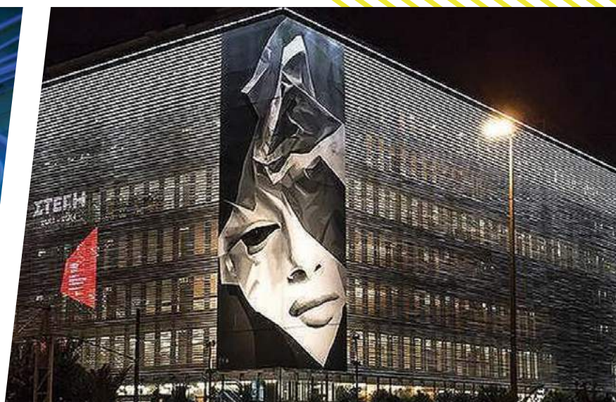
Το SurfaPore C χρησιμοποιήθηκε για την προστασία αγάλματος, λευκής, ορθομαρμάρωσης της Στέγης Ιδρύματος Ωνάση, Αθήνα, Ελλάδα .
