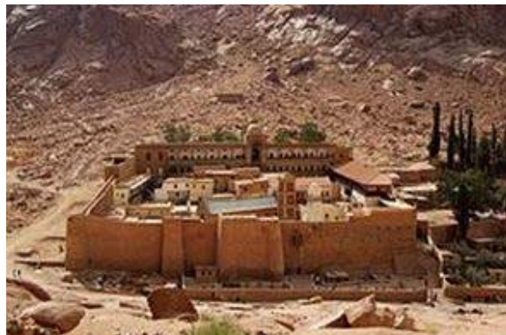
Εφαρμογή του SurfaPore FX SB στο Παρεκκλήσι των Αρχαγγέλων, στην περιοχή του Σινά, Αίγυπτος.
