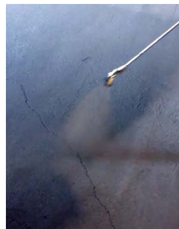
Εφαρμογή του SurfaPaint Acrylic Hard Floor σε τιμμεντοειδές δάπεδο αποθήκης.
