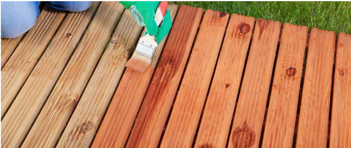
Εφαρμογή επίστρωσης SurfaPaint Deck Oil σε ξύλινο σύνθετο δάπεδο.
