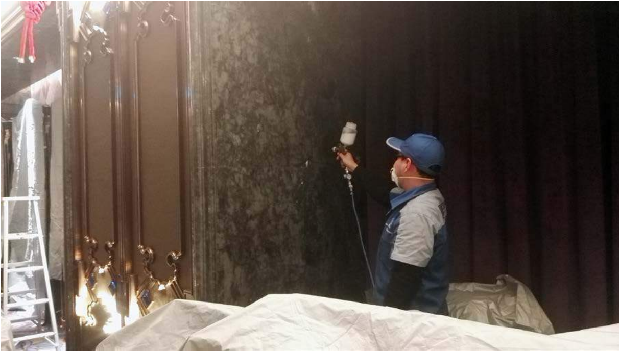
Εφαρμογή του SurfaShield T σε κάθετη μαρμάρινη επιφάνεια.
