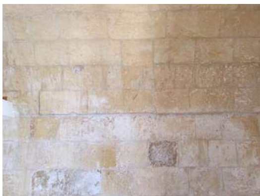
Σταθεροποίηση ασβεστόλιθου μετά από εφαρμογή του SurfaPore FX WB (άνω μέρος). Η σκόνη και η φθορά έχουν εξαλειφθεί.
