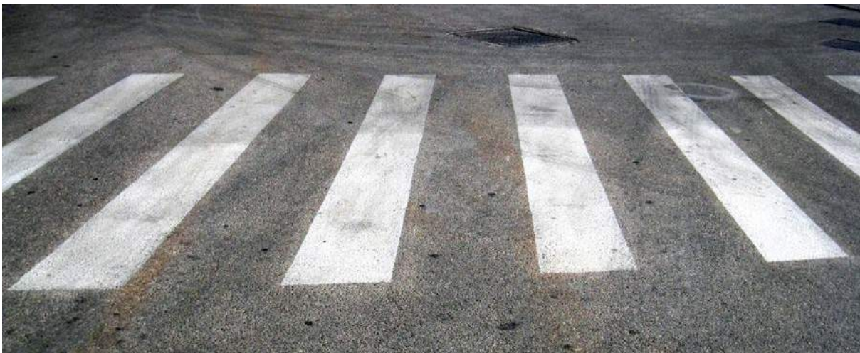
Η επίδραση του SurfaShield C σε βαριάς κυκλοφορίας διάβαση πεζών, τρεις μήνες μετά την εφαρμογή. Στην πάνω πλευρά είναι το αρχικό χρώμα διάβασης, ενώ στην κάτω πλευρά έχει εφαρμοστεί το SurfaShield C.
