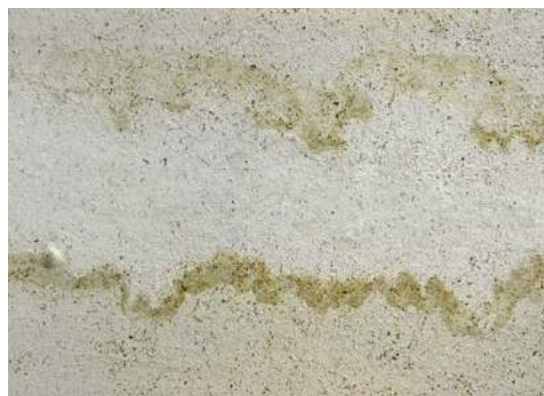
Παλιά σταθεροποίηση τσιμεντοειδούς σοβά (μεσαίο έντονο τμήμα). Η αποσύνθεση λόγω των αλάτων και της υγρασίας έχουν εξαλειφθεί.
